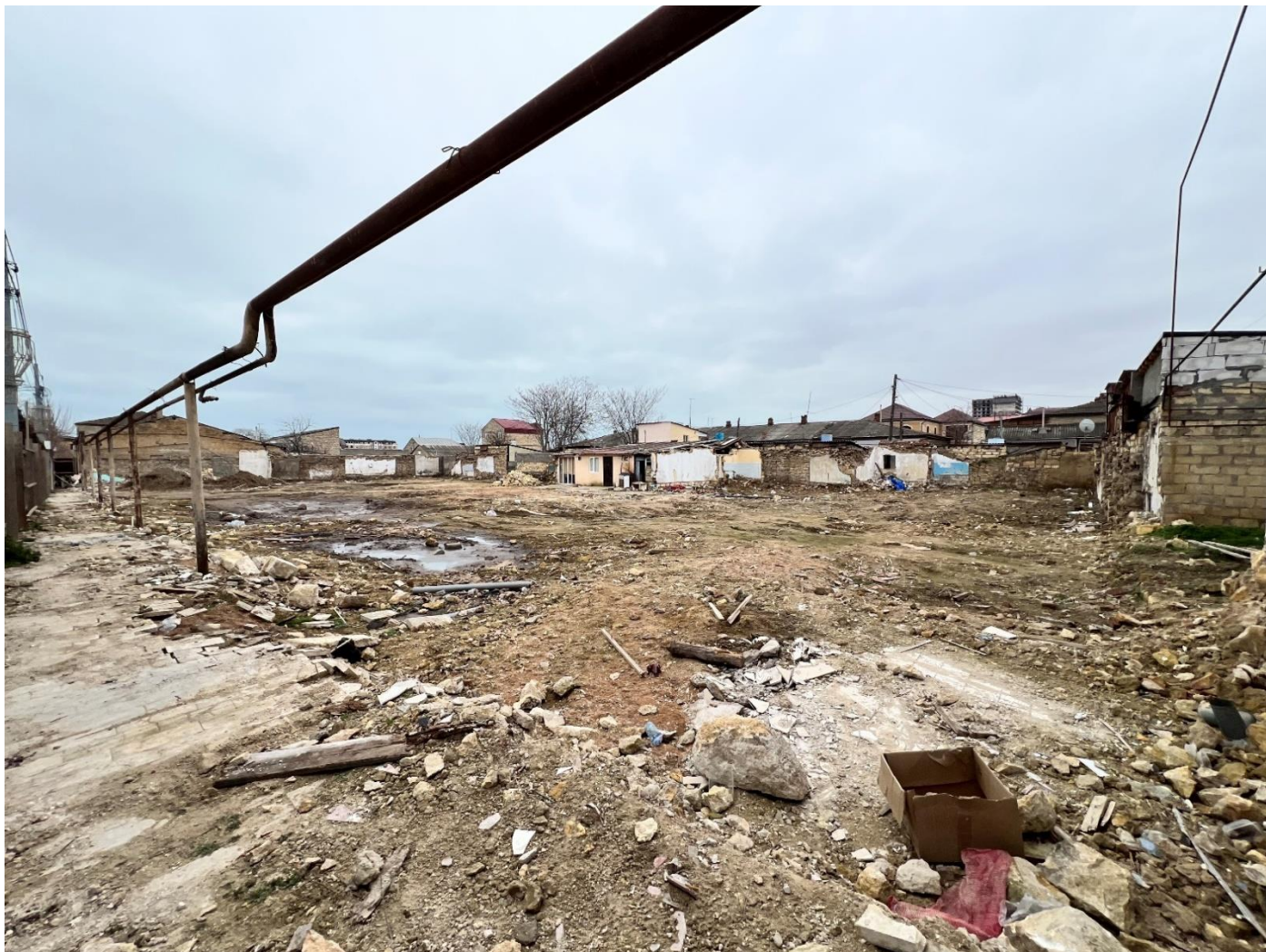
Фото 4. Общий вид земельного участка со стороны ул. Э. Пашабекова на север после сноса ветхого МКД и расчистки площадки
