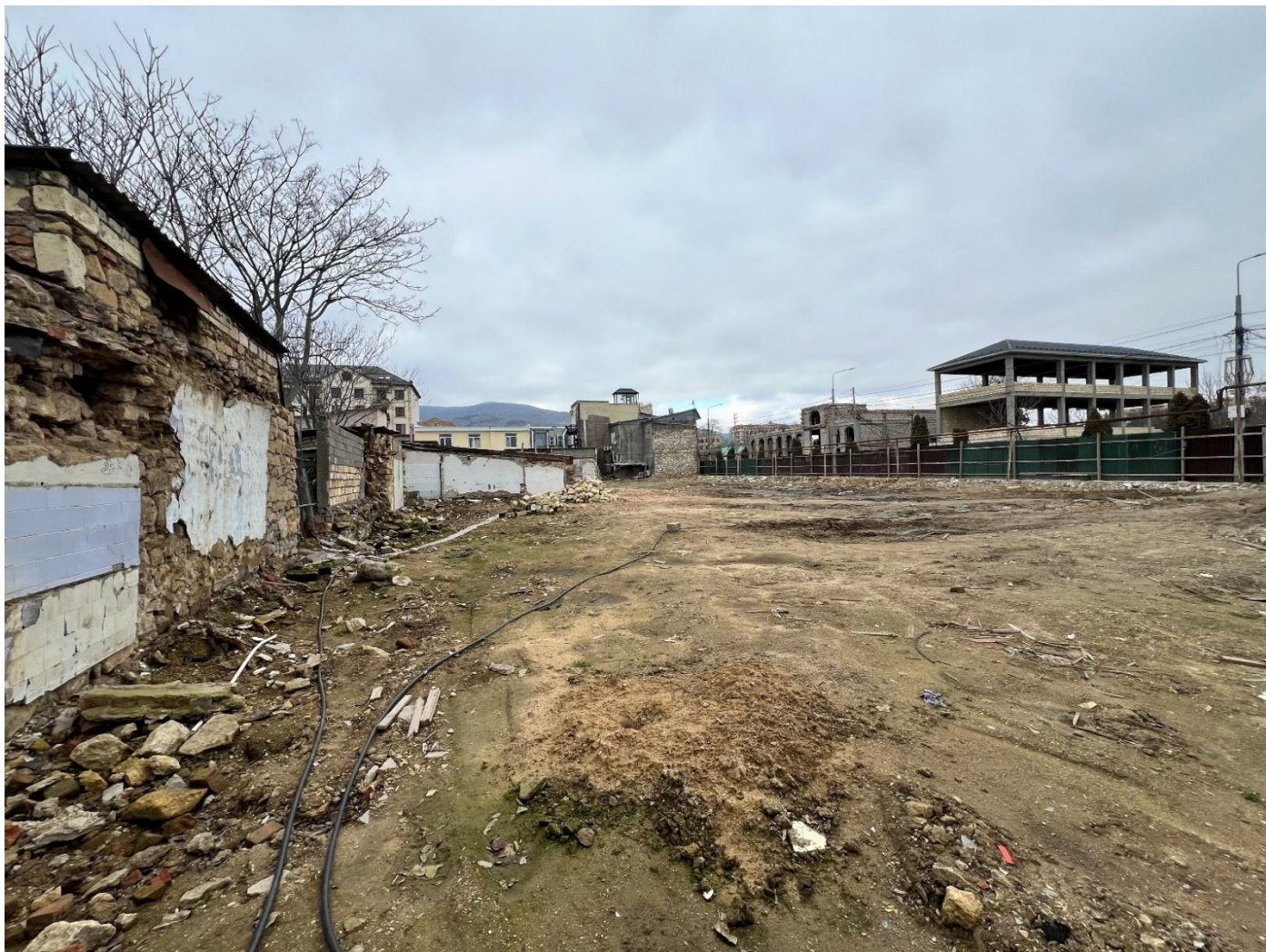
Фото 3. Общий вид земельного участка с севера на сторону ул. Э. Пашабекова, после сноса ветхого МКД и расчистки площадки
